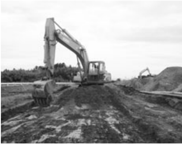
文中写真1 平成23年度重機表土剥ぎ作業(1)
