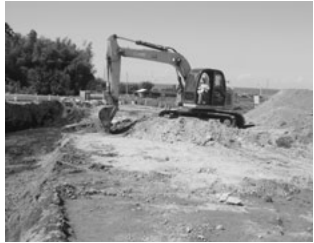
文中写真2 平成23年度重機表土剥ぎ作業(2)
