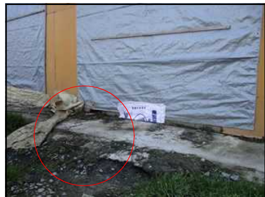
図 5. 鶏糞搬出口の破損部位（赤円部）
