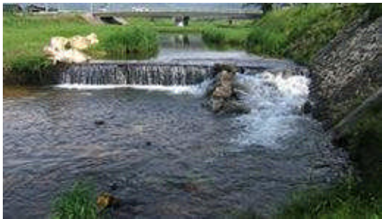
▲魚道設置後の状況
