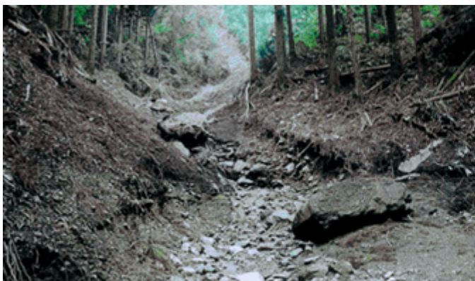
平成17年9月の秋雨前線により山腹崩壊が発生し、著しい溪岸浸食を伴って下流に土砂が流出した。
