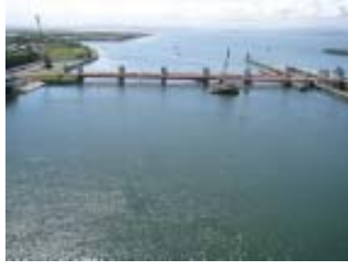
中海：中浦水門撤去工事 (中海側および境水道側の水質に及ぼす影響を定期的にモニタリングを行う)
