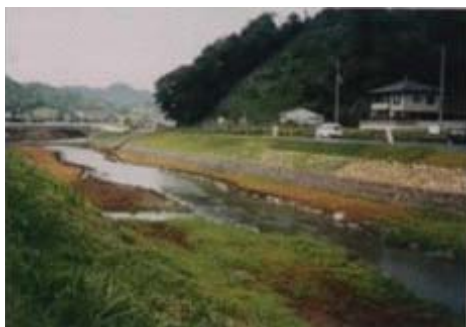
河川改修事業実施後の加茂川
