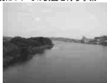
松江：大橋川拡幅事業 (宍道湖・中海について、環境影響評価に準じて、環境に及ぼす影響の調査を行う)
