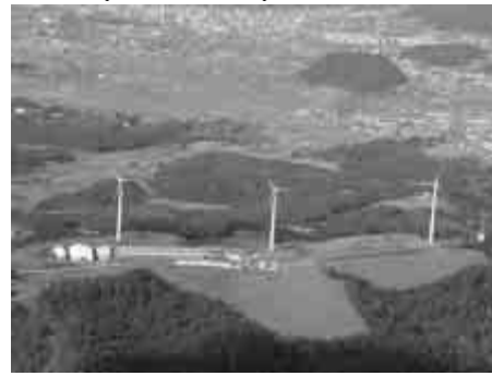
県企業局（鳥取市越路）の大型風力発電施設
