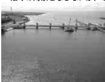
中海：中浦水門撤去工事 (中海側および境水道側の水質に及ぼす影響を定期的にモニタリングを行う)
