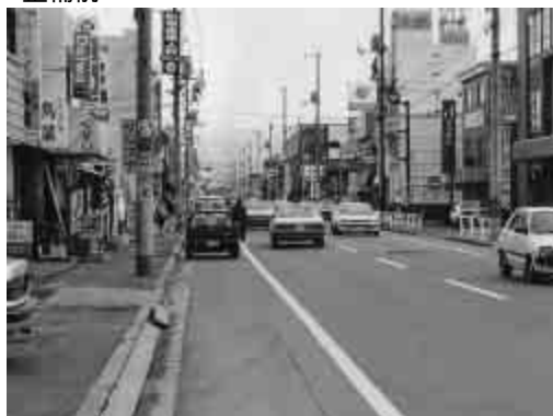
電線共同溝・街路整備の例 (都市計画道路宮下十六本松線 鳥取駅南周辺) 整備前
