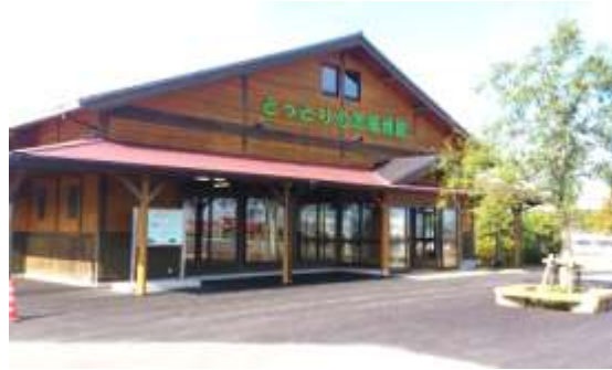
とっとり自然環境館(とっとり次世代エネルギーパーク中核施設)
