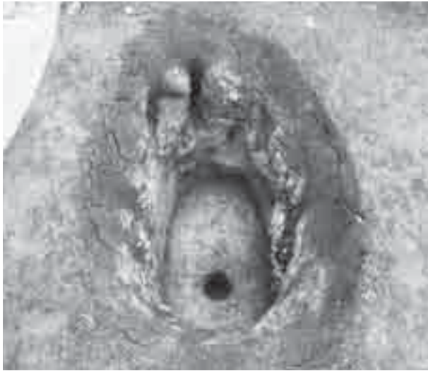
1 落とし穴15完掘状況(西から)
