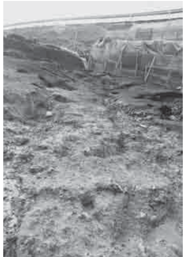
2 道6完掘状況(北東から)
