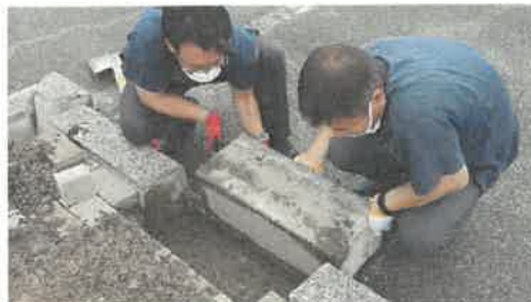
職員による道の駐駐車場縁石補修
