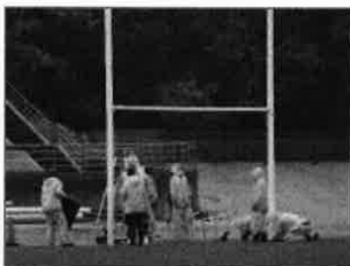
ラグビーポールの設置作業
