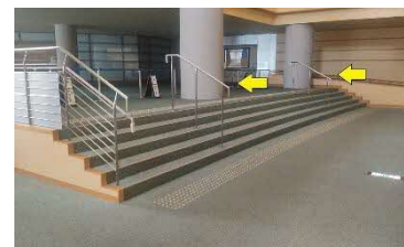
【大ホール2階ホワイエ】 利用者の声を踏まえ、階段の視認性向上と転倒防止用手摺りを設置
