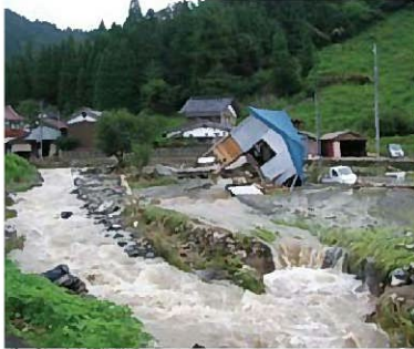
平成19年8月(集中豪雨災害) 若桜町(角谷川)
