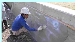
老朽化した水路壁のコーティング
