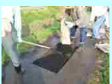
農道の部分補修
