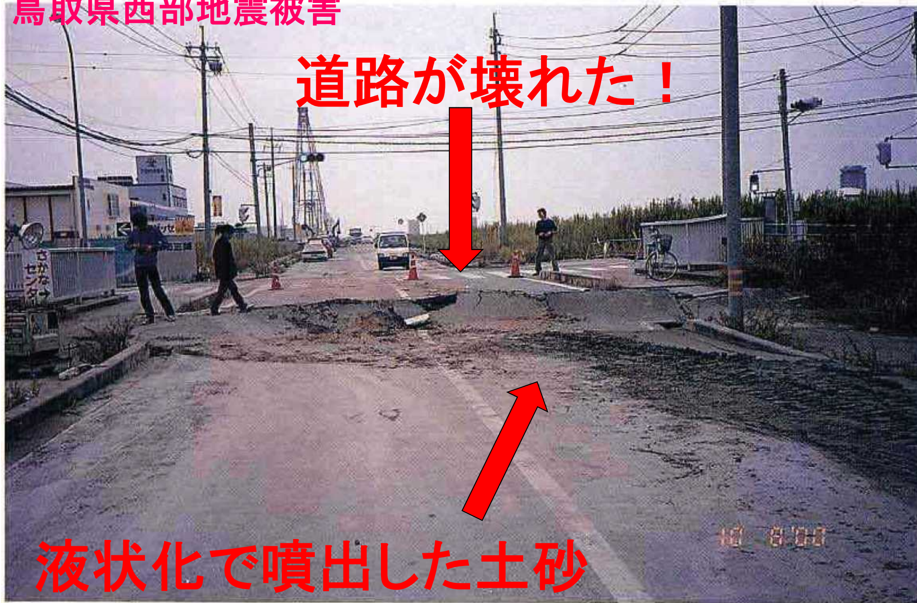
竹内工業団地内 液状化で噴出した土砂と道路の損傷（境港市）
