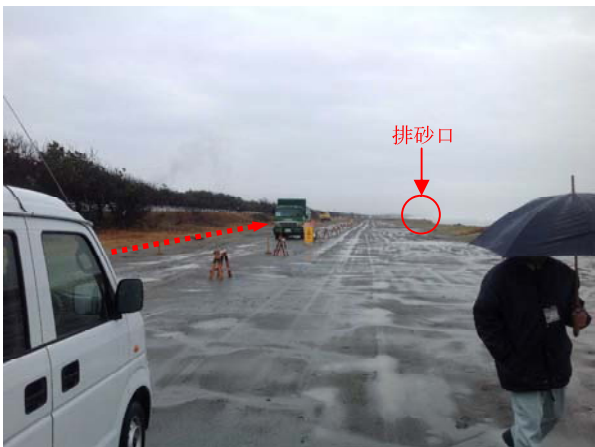
写真-8 排砂管埋設の状況
