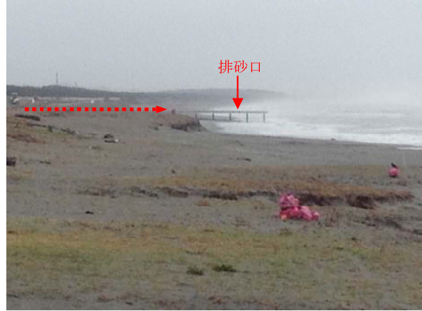
写真-7 排砂口付近の遠景
