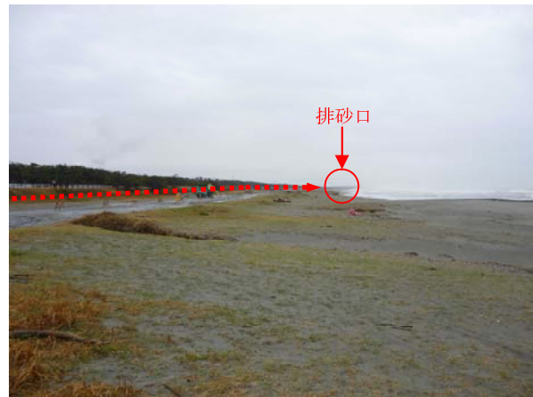
写真-9 排砂管埋設の状況
