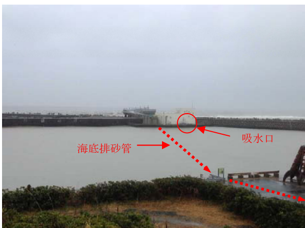
写真-4 排砂管設置状況
