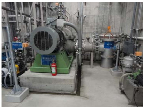
（写真7）低圧吸水ポンプ
