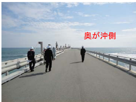
（写真8）栈橋全景
