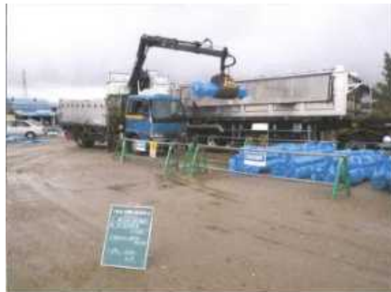
<シート養生・搬出>
