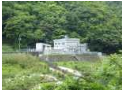
① 中国電力 川平発電所
