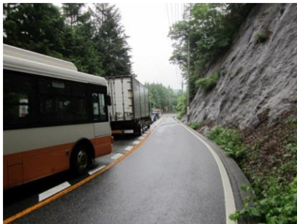
▲災害防除工事による片側交互通行
