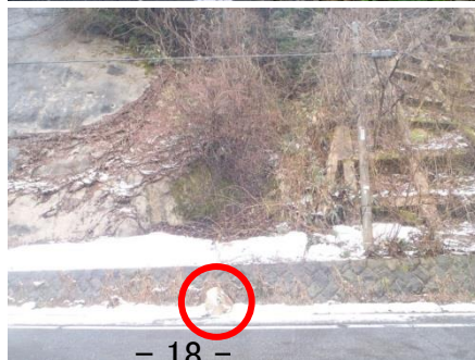
▲落石の発生状況
