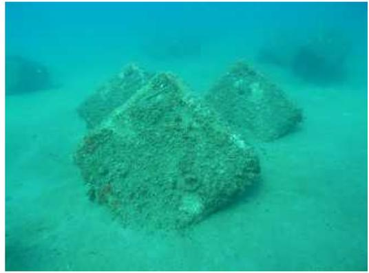
図16 漁場中央部で半分以上砂に埋没
