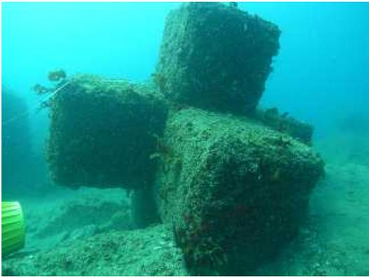
図15 瀬際で海底が岩盤なため埋没なし
