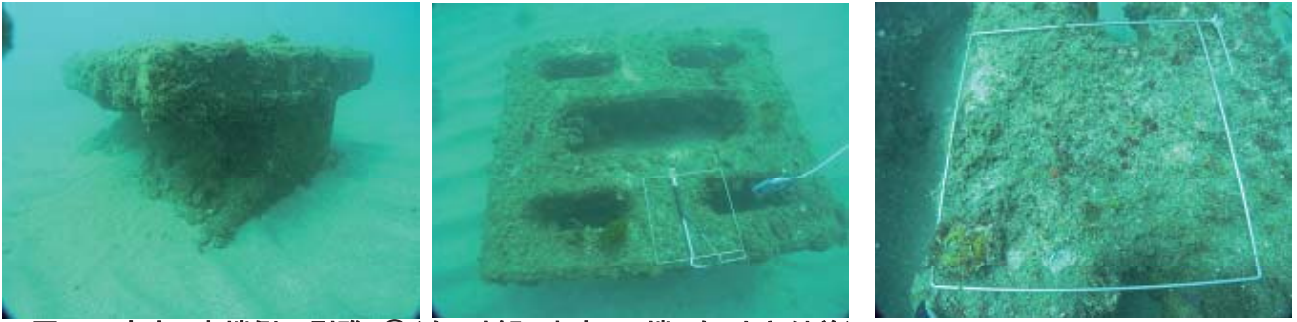
図10 定点2東端側π型礁-⑥(左:外観, 中央:天端, 右:力キ付着)
