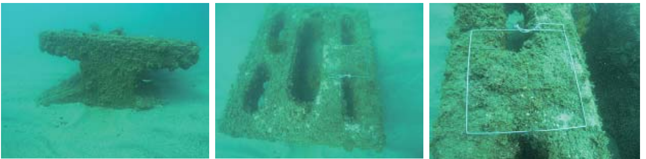
図14 定点2東端側π型礁-⑩(左:外観, 中央:天端, 右:力キ付着)
