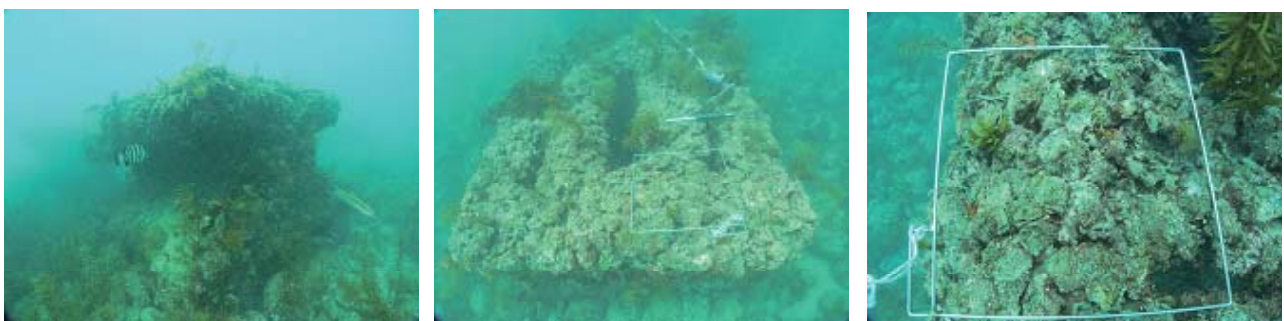
図4 定点1西端側π型礁-②(左:外観, 中央:天端, 右:カキ付着)
