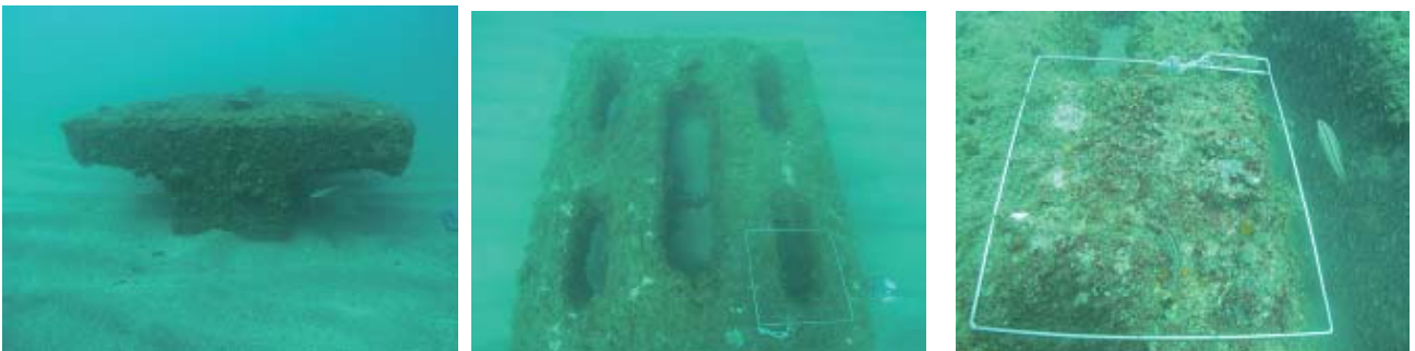
図13 定点2東端側π型礁-⑨(左:外観, 中央:天端, 右:力キ付着)
