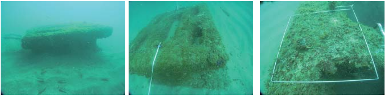
図12 定点2東端側π型礁-⑧(左:外観, 中央:天端, 右:力キ付着)
