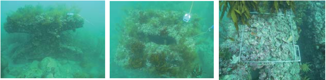
図6 定点1西端側π型礁-④(左:外観, 中央:天端, 右:カキ付着)
