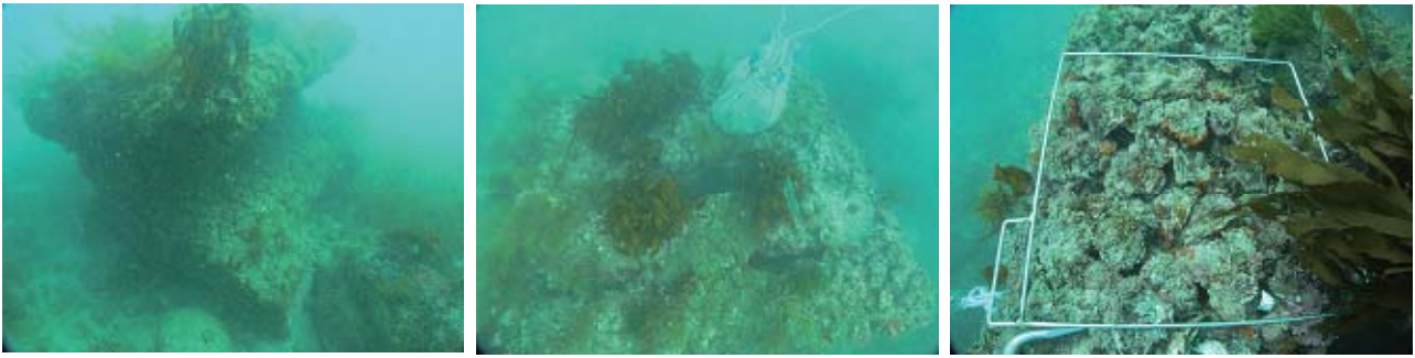
図5 定点1西端側π型礁-③(左:外観, 中央:天端, 右:カキ付着)
