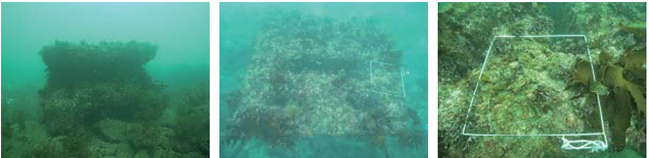
図24 名和地先型増殖場調査点π型礁-⑧(左:外観, 中央:天端, 右:力キ付着)
