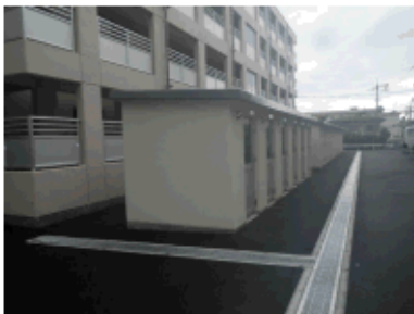
（新設外部廊下、倉庫）
