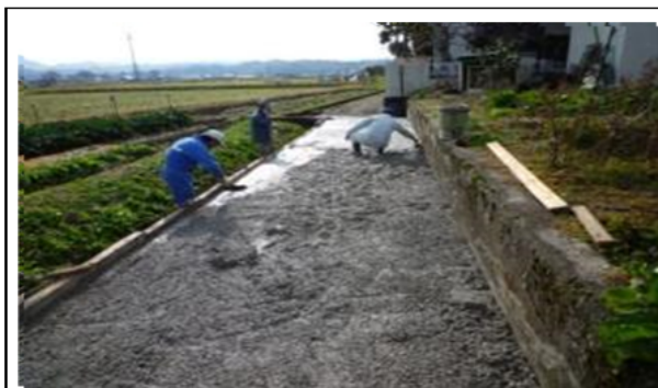
砂利道のコンクリート舗装
