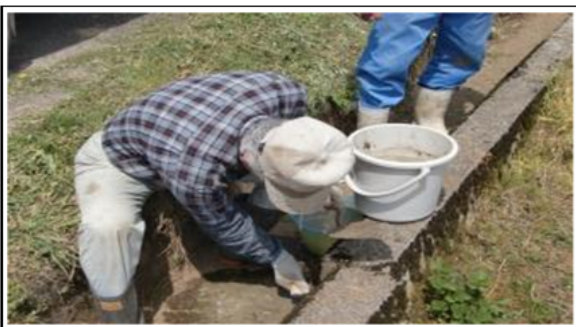
水路の目地詰め
