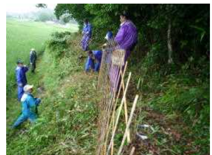
イノシン柵の共同設置作業
