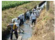
水路の泥上げ
