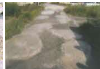
農道の窪みの補修
