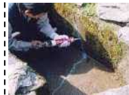
水路のひび割れ補修
